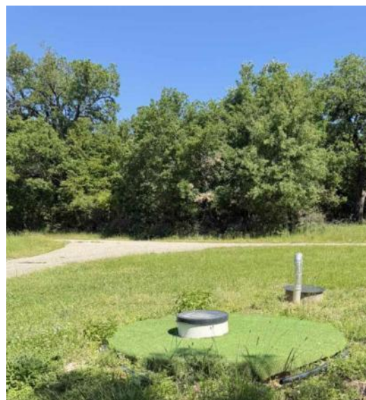
4. kép: Átemelő medence, nyomásfokozó szivattyú
